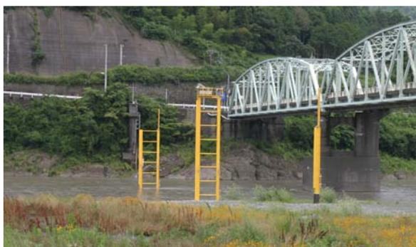
図-3 観測地点 B に設置した河床高自動計測システムの全体像
