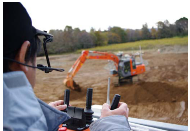
写真-5 直接目視による操作
