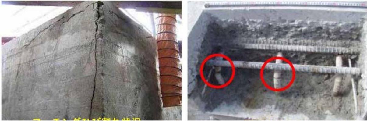
写真4.4. D橋の損傷状況(左：側面のひび割れ状況，右：隅角部の鉄筋破断状況)
