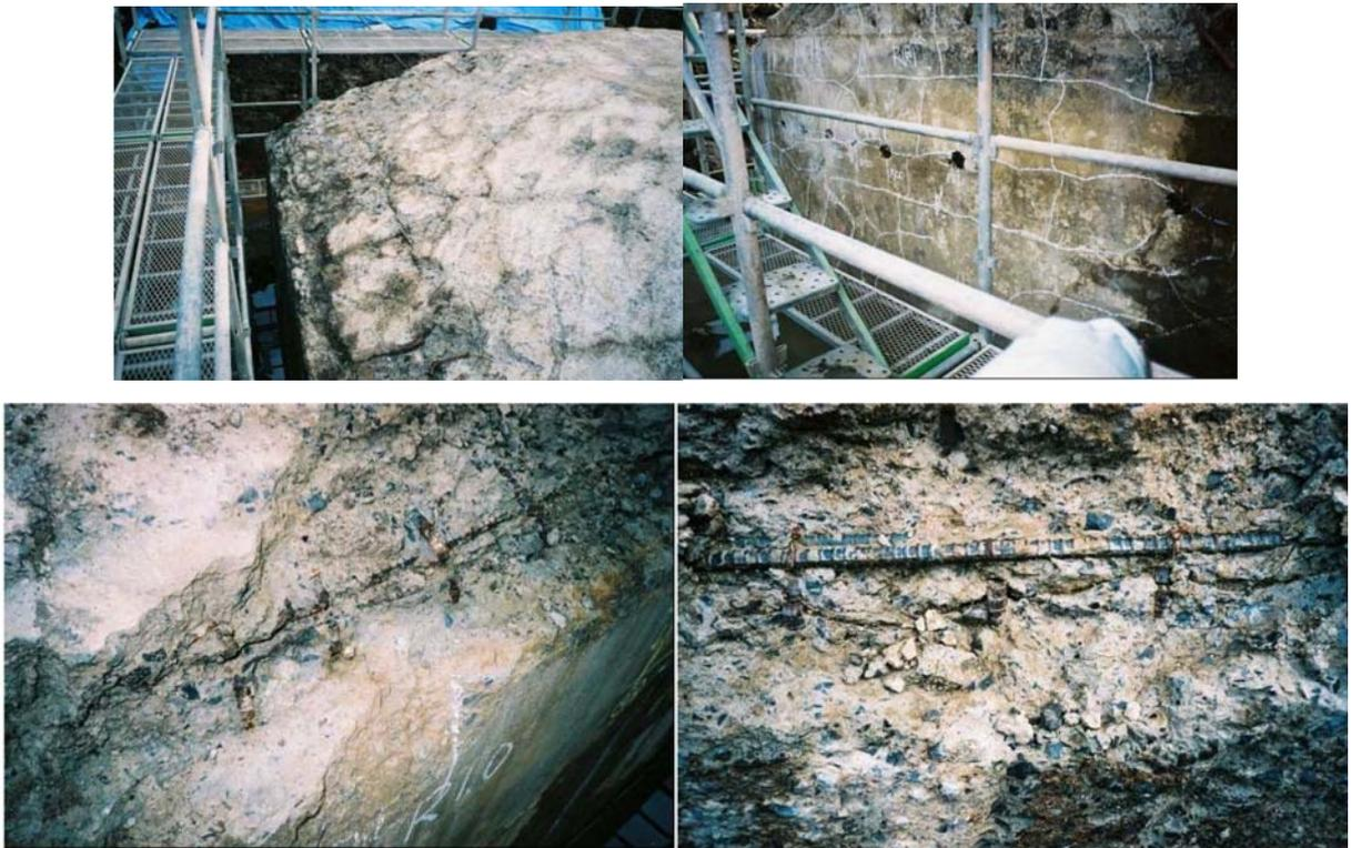
写真4.2. B橋の損傷状況(上段：ひび割れ状況, 下段：鉄筋破断状況)
