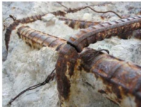
写真4.3. C橋のフーチング隅角部の鉄筋破断
