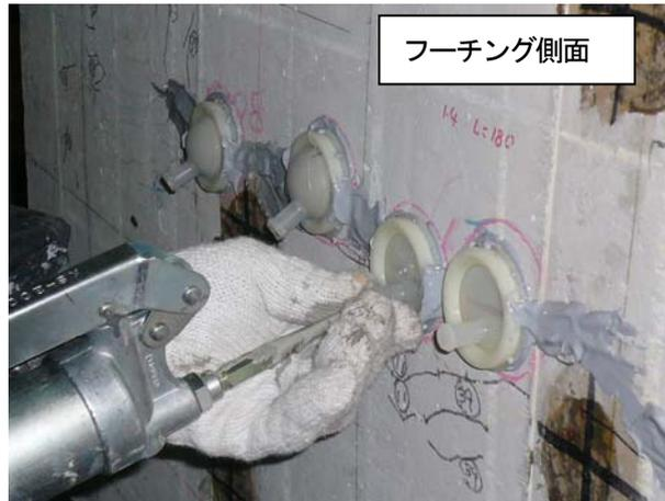
写真4.7 ひび割れ充填剤注入時の様子
