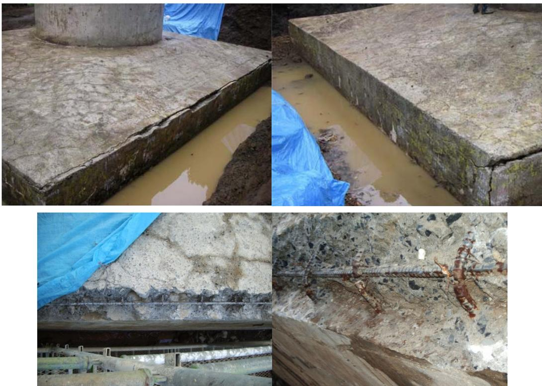
写真4.1. A橋の損傷状況(上段：ひび割れ状況，下段：鉄筋破断状況)
