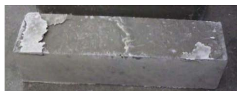
写真-1.1 ケースBの表面剥離発生状況
