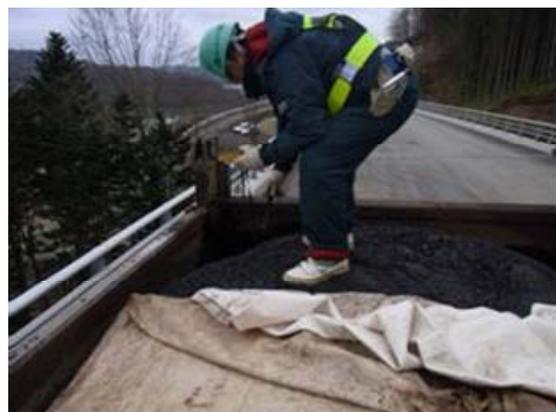
写真-1 到着時の温度測定状況
