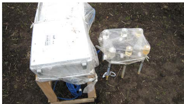
写真-3 テンシオメータ設置状況
