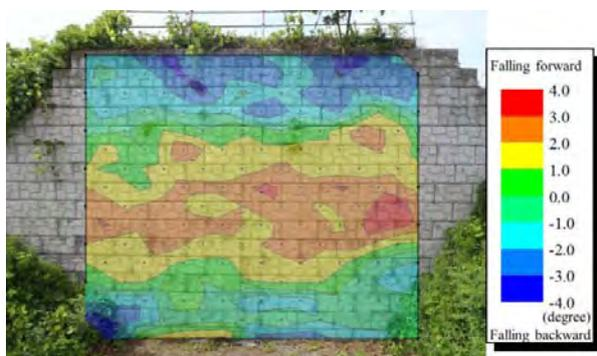
図-13 壁面ブロックの傾斜角
