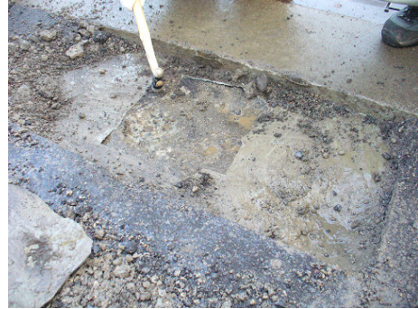
(a) 防水層の接着性の低下
