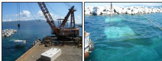
写真-1 嵩上げ施工状況
