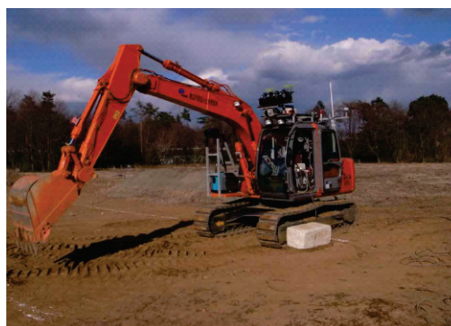
写真-8 実験に使用した油圧ショベル（遠隔機能付き）
