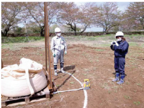
写真-13 設置位置のズレ計測状況
