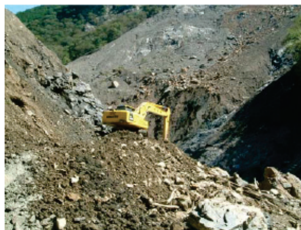
写真-4 現場状況
