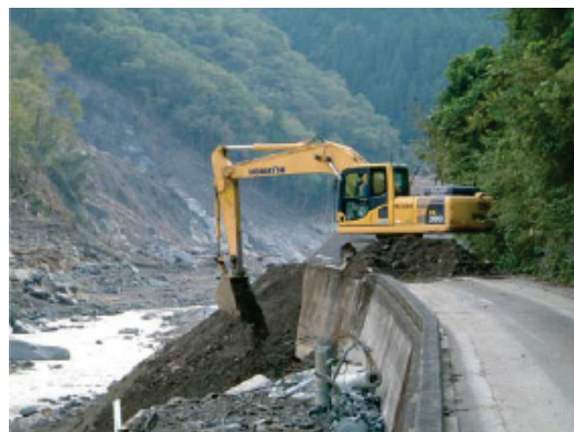
写真-7 復旧のための搬路の整備
