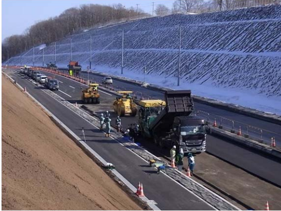
写真-1 試験施工状況（白老町）
