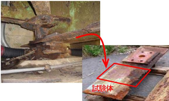
写真-1 腐食欠損試験体の撤去前状況
