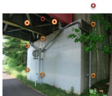
図-6 実橋におけるコンクリート表面温湿度の長期観測
