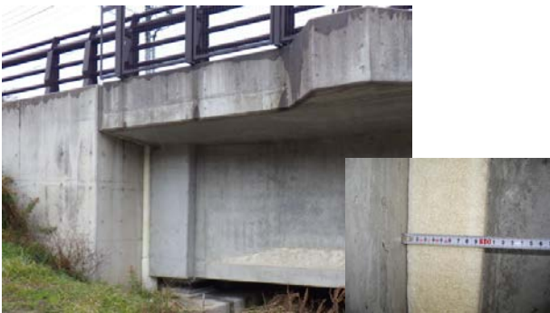
写真-2 PC 橋桁端部とその遊間の測定状況
