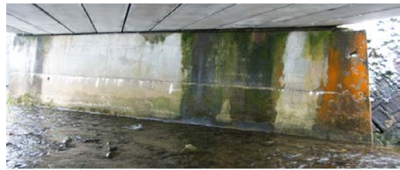
右岸橋台前面
