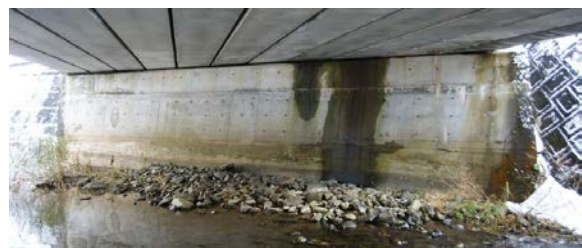
左岸橋台前面
