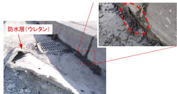
(c) 車歩道境界近傍の防水層の状況（舗装撤去後）
