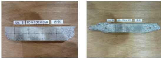
図-9 劣化状況例
