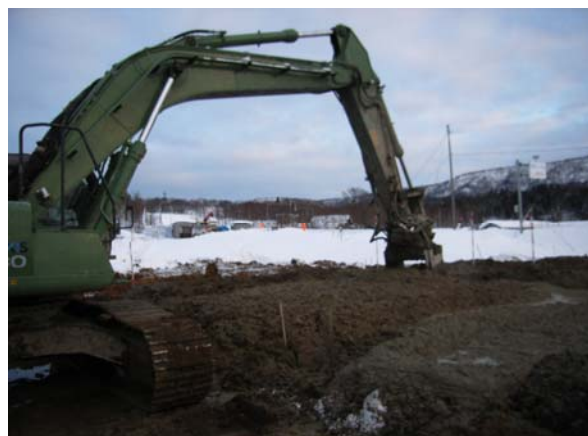
図-10 冬期施工の様子
