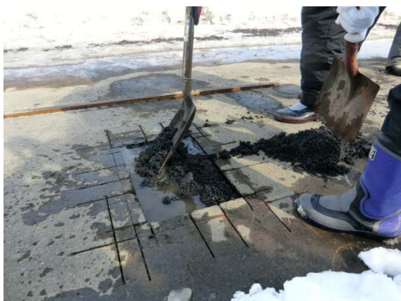
図-25 擬似ポットホールへの常温混合物投入状況
