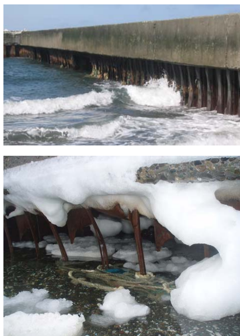
図-1 オホーツク海に面した導流堤の鋼矢板の損傷例
