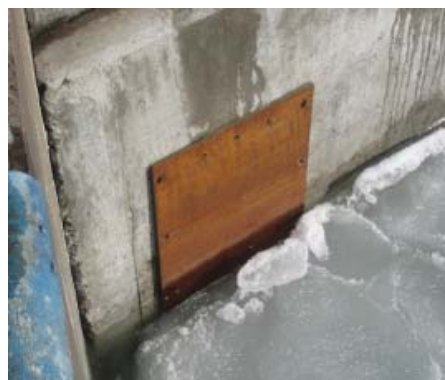
図-21 暴露試験状況(網走港内)
