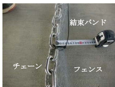
図-16 ウニ侵入防止フェンス
