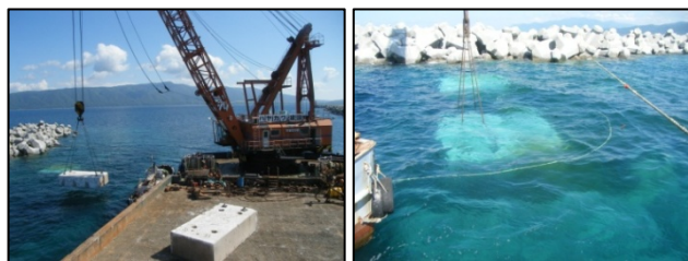
図-6 嵩上げ施工状況
