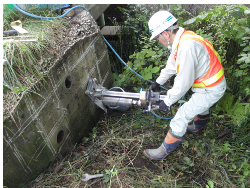
写真-4 コア採取の状況（1-2橋）
