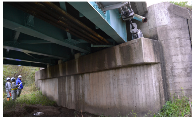
写真-3 外観調査の状況（橋台）
