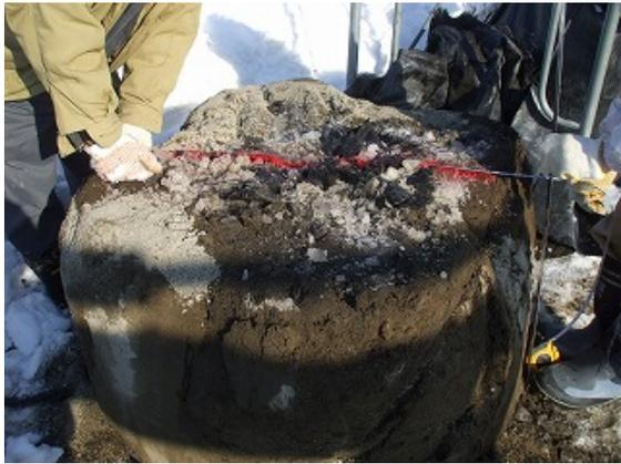
写真-6 大型土のうの開削状況
