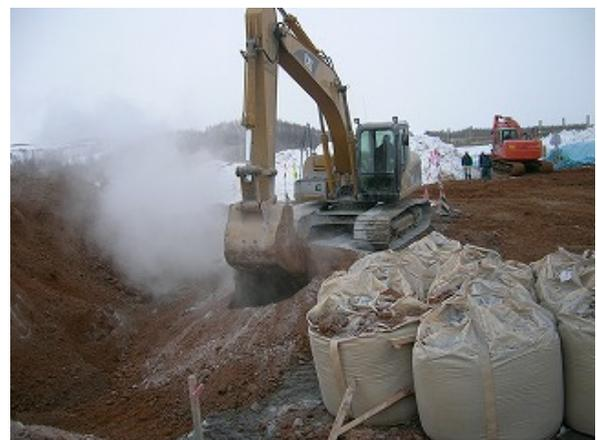
写真-4 冬期の固化材による改良の例
