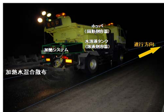
写真-4 試作機による散布状況
