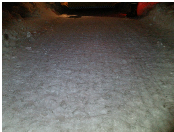
写真-14 施工後の状況
