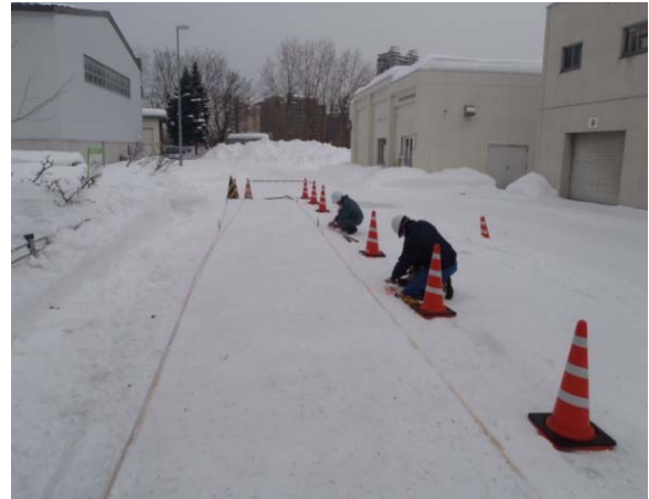
写真-10 雪氷路面作製状況
