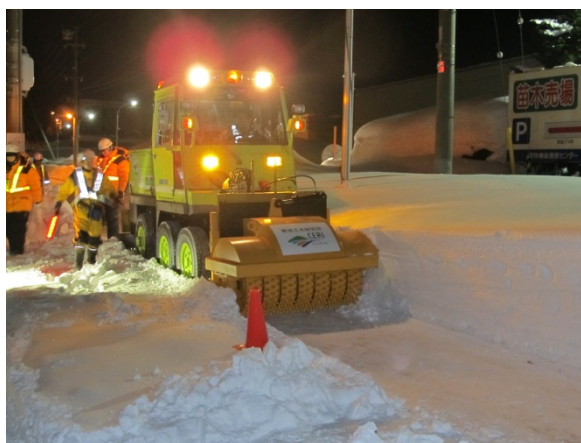
写真-13 現道歩道施工試験
