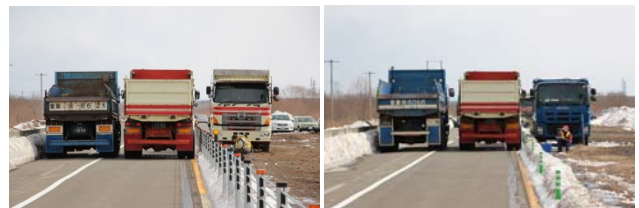
写真 2 大型車同士のすれ違い状況（左：ワイヤーロープ式防護柵区間、右：ラバーポール区間）
