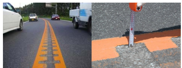
写真 1 ランブルストリップス（左：R237、右：R275）
