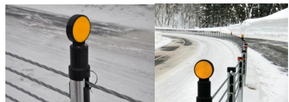
写真5 一般国道 275 号天北峠に設置されたゴム製デリネーター
