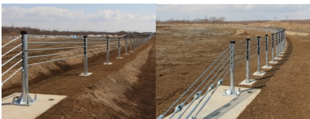
写真3 苫小牧寒地試験道路での試験施工 (左：サグ区間、右：曲線区間)
