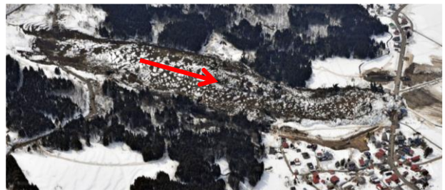
写真-3 ケース扇状地または谷底部の事例 国川地すべり（新潟県）
