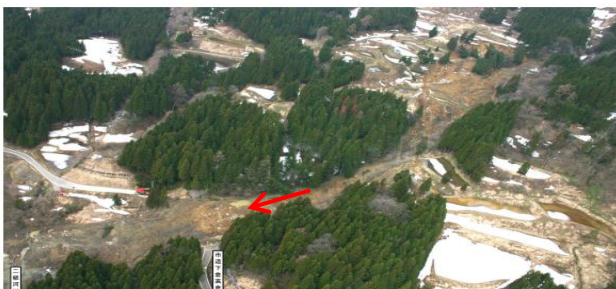
写真-2 ケース溪流の事例 下倉地すべり (新潟県)
