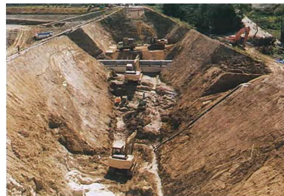
図-4.3 金城池の補修状況 1)
