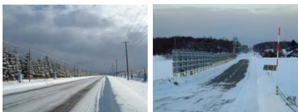
図2 道路防雪林・防雪柵（吹き払い柵）の設置状況
