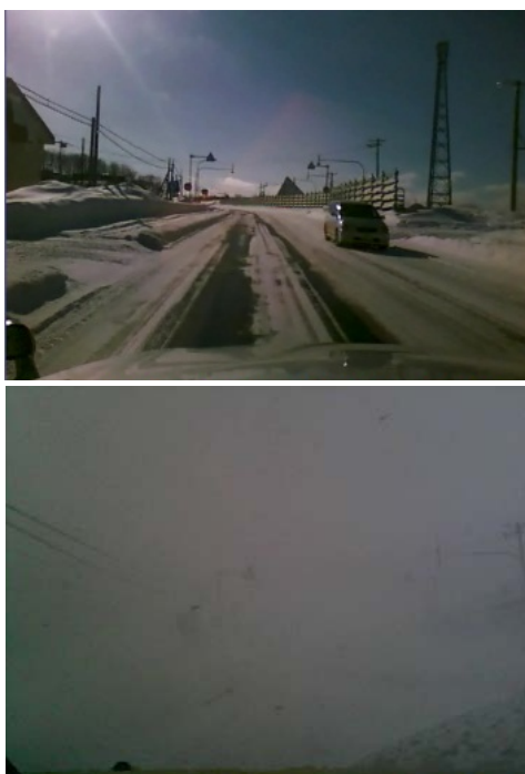
図 5 防雪柵端部の晴天時の状況(上)と視程障害状況(下) (一般国道 232 号 KP53.1 付近)
