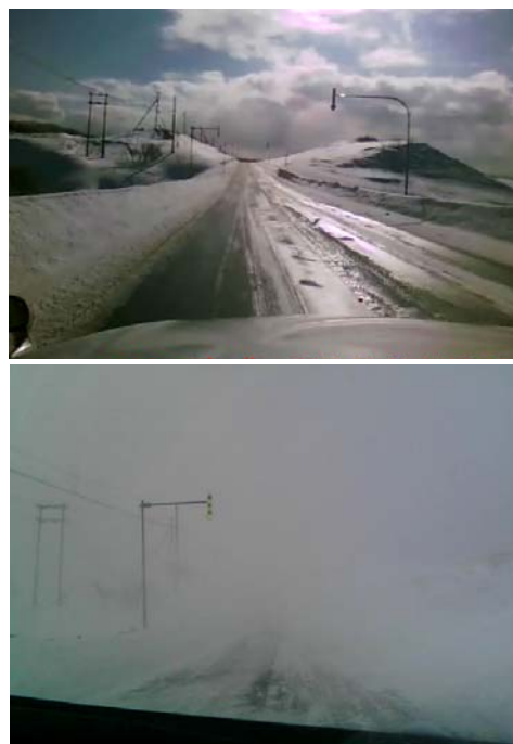
図 6 切土盛土境の晴天時の状況(上)と視程障害状況(下) (一般国道 232 号 KP59.2 付近)
