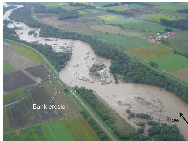
図-18 堤防被災時の状況（2011 年 9 月 7 日撮影）
