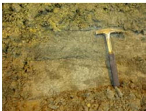
写真-1 トンネル補修時の路床部の岩盤の状況
