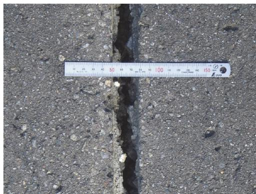
写真-1 既設アスファルト舗装のひび割れ箇所
