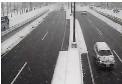
写真-1 ロードヒーティング融雪状況
