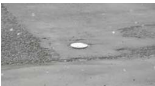
写真－4 路面センサーの設置状況③
