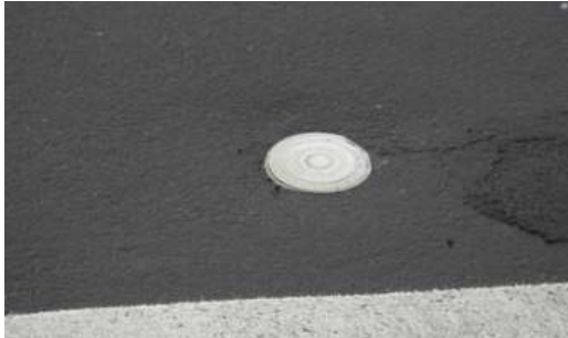
写真－2 路面センサーの設置状況①
