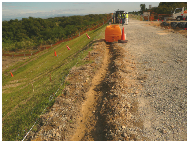
写真-1 堤体注水用溝設置状況
