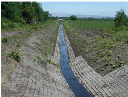
写真-1 連節ブロック型排水路
