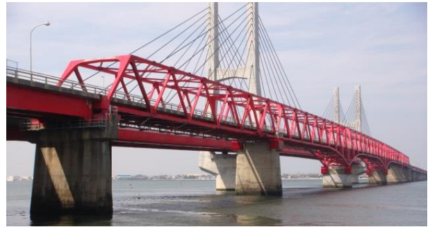
図-2.1 撤去前の対象橋梁(手前)と新橋(奥)
