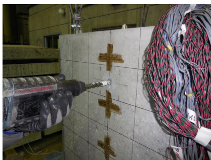
写真-6 先導孔へのドリル削孔の状況
