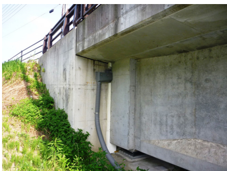
写真-2 2 径間連続 PC 橋における試験的な設置 (ポリエチレン製排水装置を 100mm の遊間に挿入)
