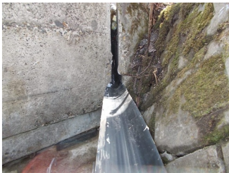
写真-1 単径間 PC 床版橋(G 橋)における試験的な設置 (ゴム製排水装置を 70mm の遊間に挿入)
