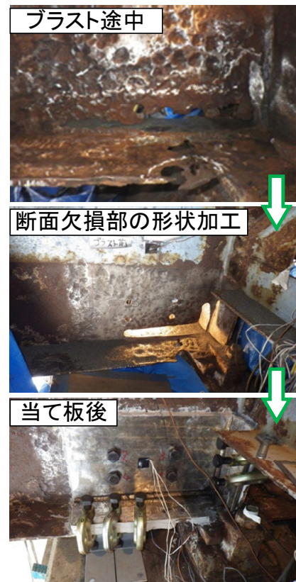
写真-9 当て板補強の施工フロー
