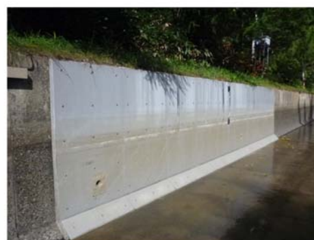
図-67 FRPM板の施工7年後の状況(南面)
