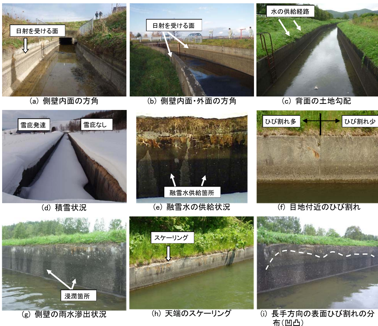
図-13 RC開水路の凍害診断における目視調査のポイント
