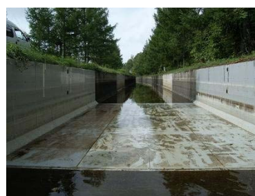
図-61 施工後の状況（灌漑期間1回終了時）
