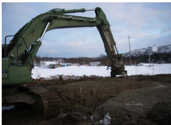
図-15 冬期施工の様子
