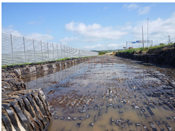
図-22 ジオテキスタイル敷設状況
