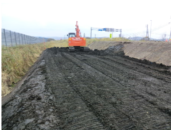
図-23 2次盛土の施工状況
