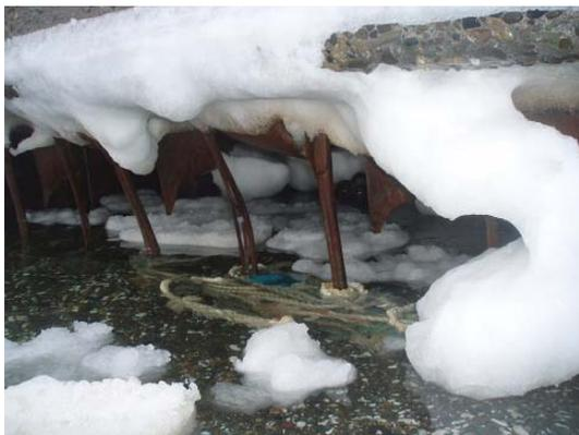
図-1 (b) オホーツク海に面した導流堤の鋼矢板の損傷例
