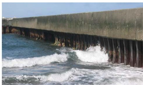
図-1 (a) オホーツク海に面した導流堤の鋼矢板の損傷例
