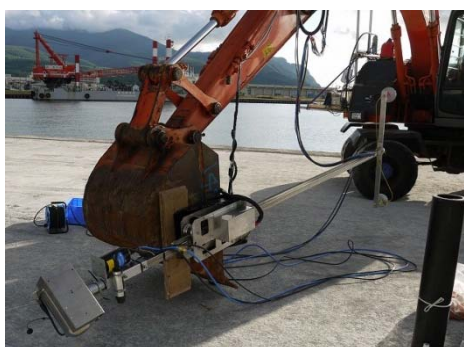
図-7 ソナー昇降装置取付状況
