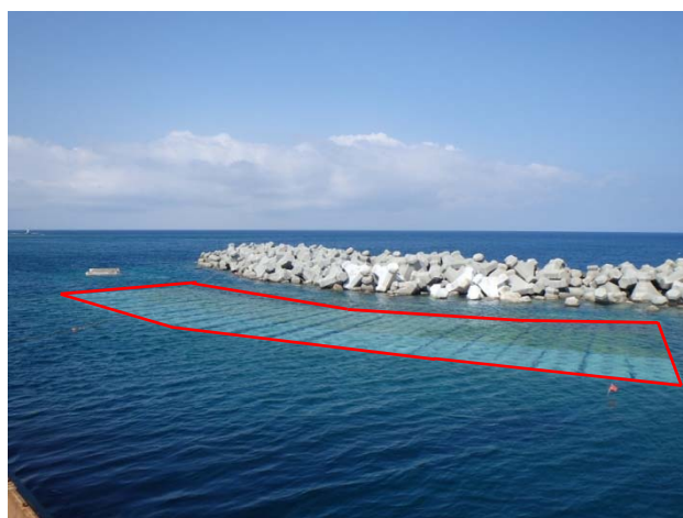
図-19 嵩上げ改良(赤枠部)
