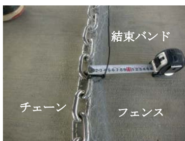
図-23 ウニ侵入防止フェンス
