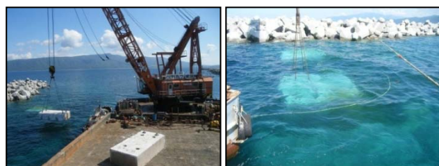
図-6 嵩上げ施工状況
