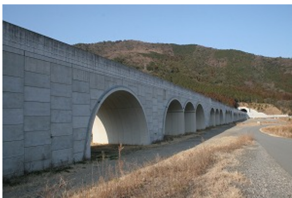
写真-1 連続アーチカルバート構造の事例④
