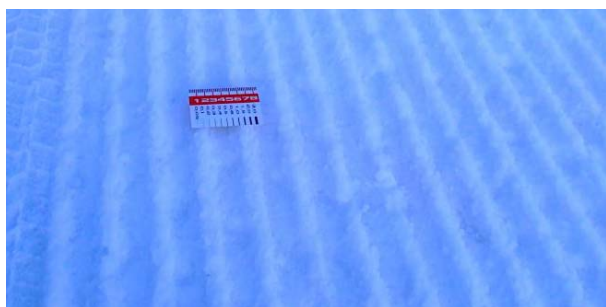
写真-17 雪氷路面処理装置施工後のアイスバーン
