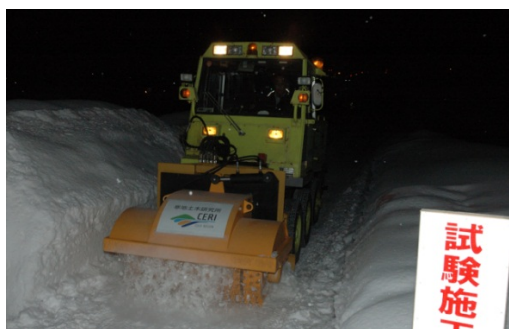
写真-12 現道歩道の施工状況
