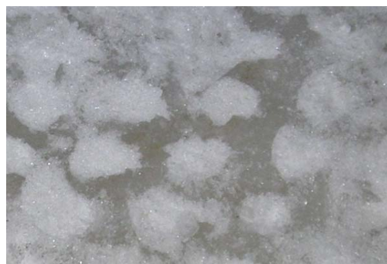
写真-15 残った滑りやすい平面部(1回施工)
