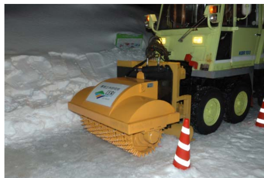
写真-14 雪氷路面での施工状況
