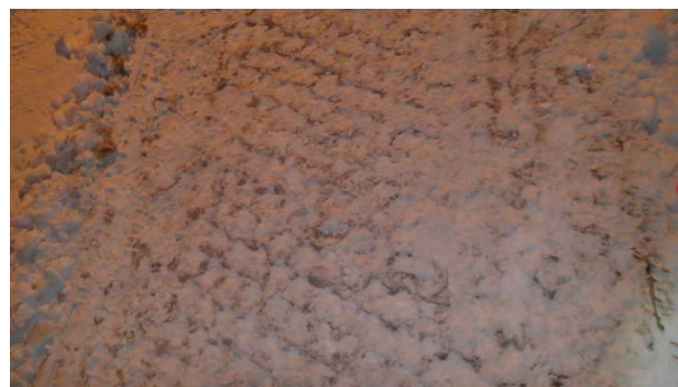
写真-18 雪氷路面処理装置施工後の圧雪路面
