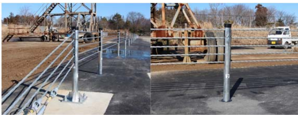
写真5 防護柵設置状況
