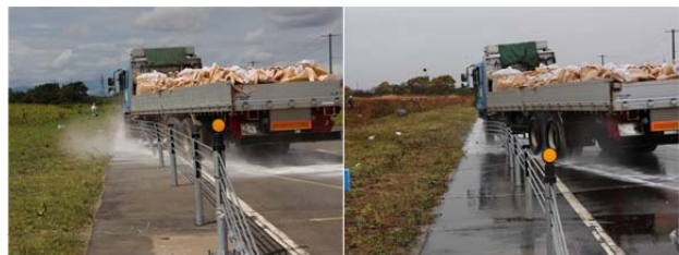
写真3 2種類の仕様の防護柵設置状況 (左: 仕様1, 右: 仕様2・張力20kN)
