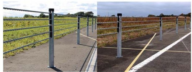
写真2 2種類の仕様の防護柵設置状況 (左: ワイヤーロープ5段, 右: 同4段)
