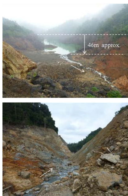
図-11 決壊後の天然ダム
