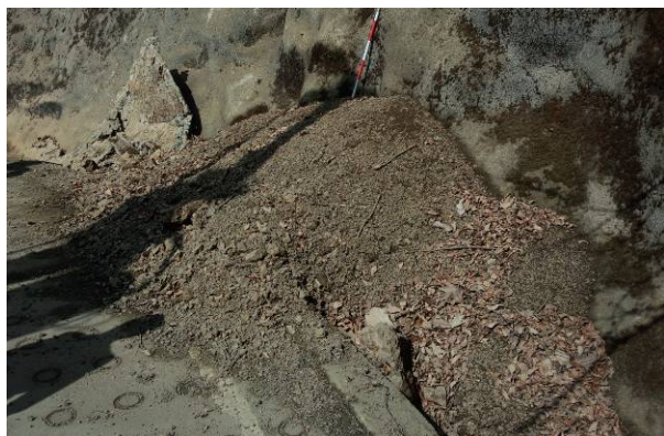
(c) 崩落土砂の状況
