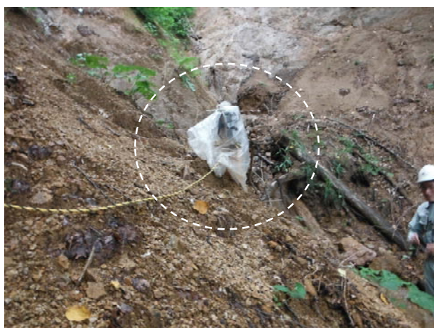
写真-2.2 設置状況
