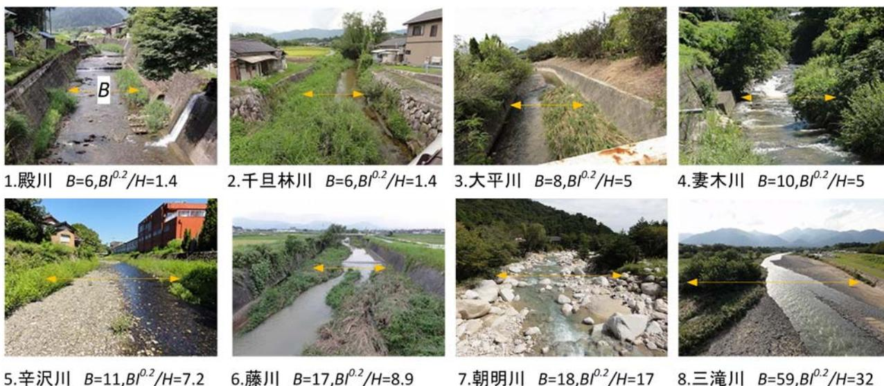
図-5  $Bl^{0.2}/H$ と河道景観との関係 (写真中の両矢印は設定した川幅を示す)
