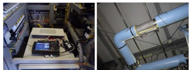
図-2 計測機器設置状況(温水式)
