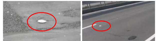
図-12 路面センサーの設置状況②
