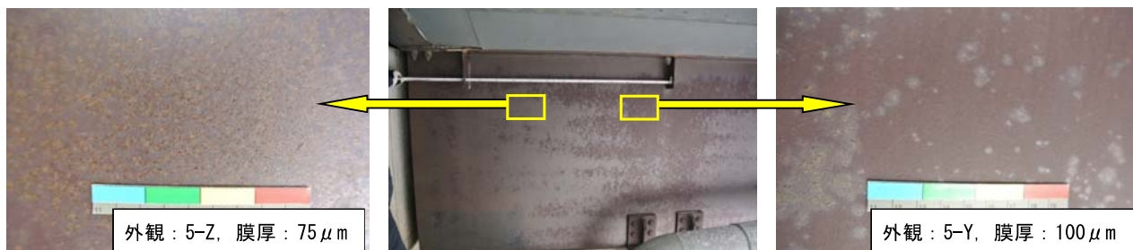
図-11 さびむら個所の外観と膜厚（経過 20 年）
