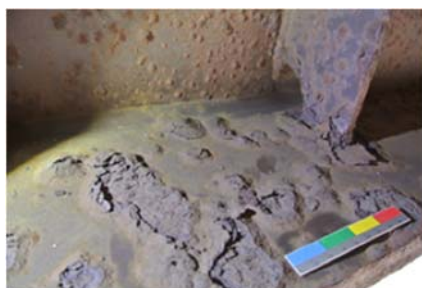
図-12 こぶ状さび （経過 28 年, 離岸 5km）
